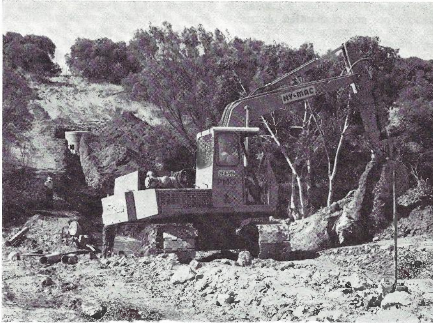
Fig. 7. — The Hymac 5/8 yd. Excavator.
